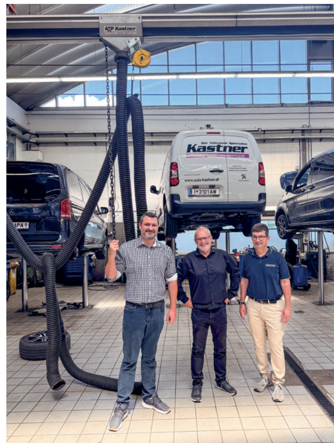
(v.l.): Hermann Hell, Andreas Kurz und Ernst Kieslinger vor der Becker-Unterflur-Hebebühnen und einer 23 Jahre alten Abgasabsaugung mit Saugschlitzkanal, von der Firma Kastner installiert.
