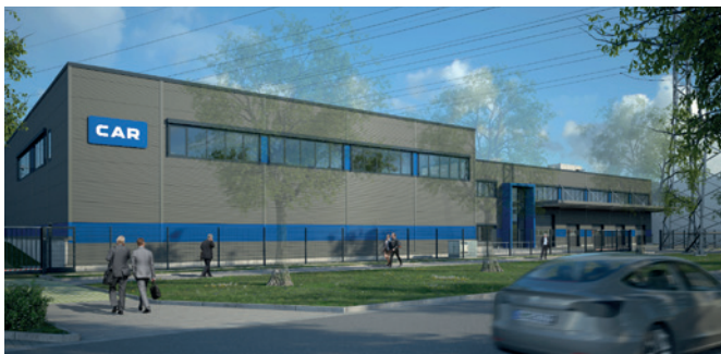
2024 Neues Car-Zentrallager in Unna.
