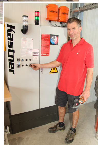
Erwin Garzaner vor dem Steuerungskasten: Jeder der fünf Stempel lässt sich individuell und kabellos via Funkfernbedienung ansteuern
